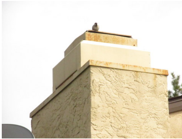
Chimney cap rust
